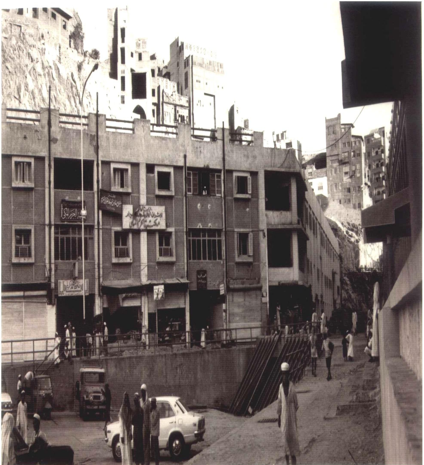
صورة رقم (٣) : وفيها تظهر صورة مبنى مشروع الحرم على الكتف الشمالي لجبل الصفا ، والمسافة الفاصلة بينه وبين جدار المسعى والتي اقتطعت من جبل الصفا .
